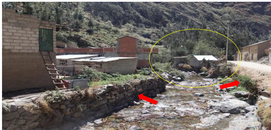
FIGURA N°02: SE OBSERVA SEGUN LA FOTO QUE EN NINGUNA DE SUS MARGENES SE CUENTA CON ALGUN TIPO DE DEFENSA RIBEREÑA, LOS MISMOS POBLADORES HAN COLOCADO PIRCA DE PIEDRAS LO CUAL NO GARANTIZA SU SEGURIDAD
